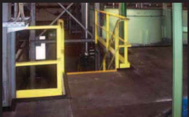
► Fogli Xtra Grip, tagliati a misura e fissati su piattaforma di griglia
